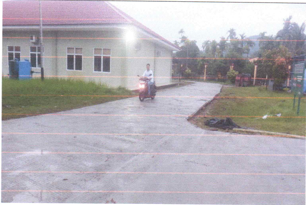
Gambar 4 : Dokumentasi Betonisasi Jalan Lingkar RSUD
